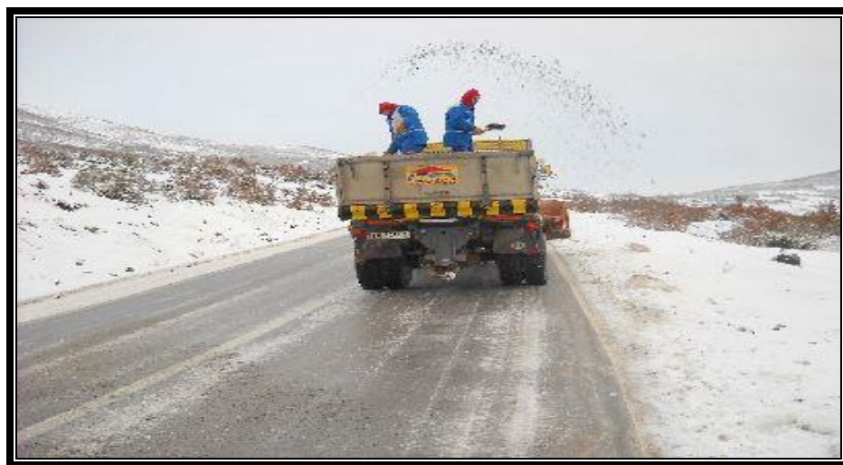
Fig. Ilustruese: Shpërndarja e kripes në mënyrë manuale
