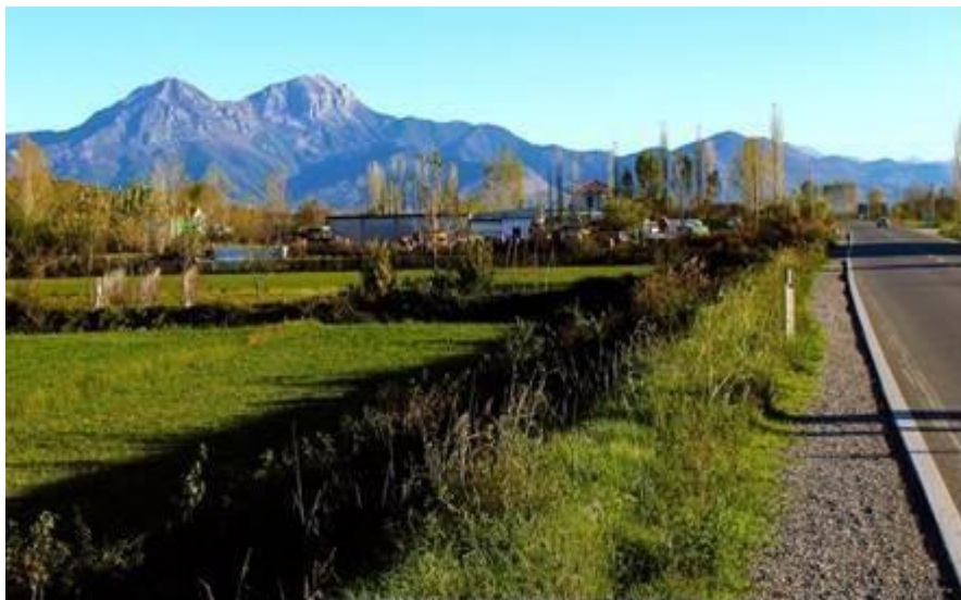
Figura 3-2 Pamje e nënseksionit të dytë (rreth 12,6 km) e seksionit 1 të AIC
