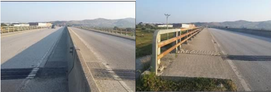
Figura 3-36 Urë ekzistuese mbi Lumin Shkumbin (gjatësi 300 m) - Pamje platformës së urës dhe trotuarit
