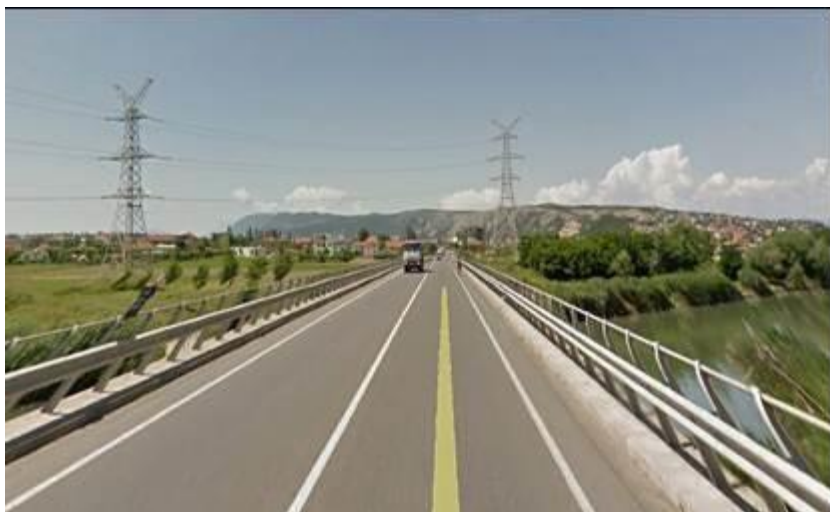
Figura 3-32 Pamje e platformës ekzistuese të urës mbi Lumin Drin në Lezhë (gjatësi 225 m)
