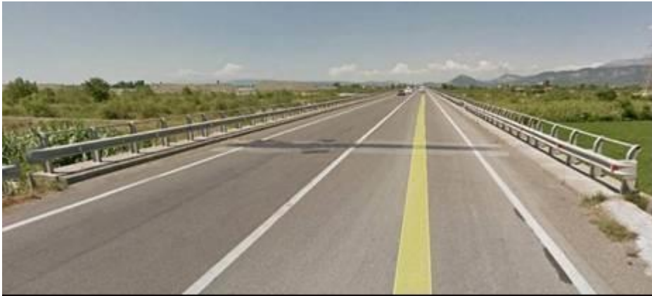
Figura 3-34 Pamje e platformës ekzistuese të urës mbi Lumin Mat (gjatësi 625 m)
