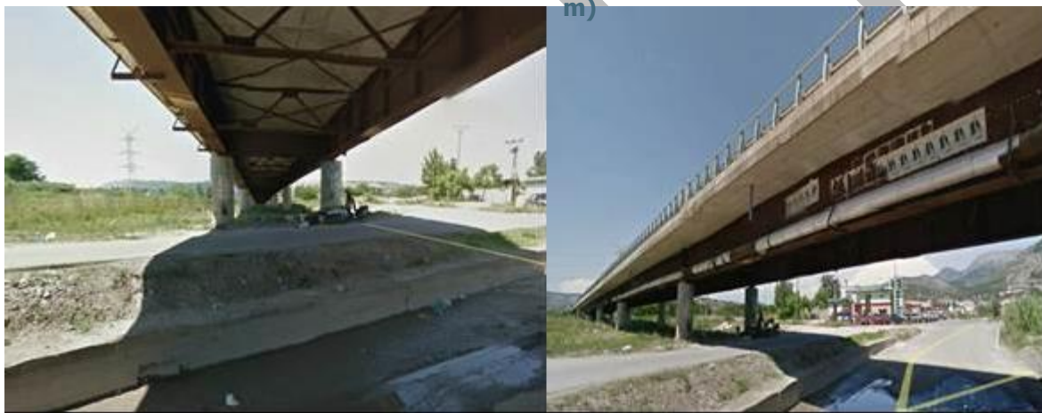
Figura 3-33 Urë ekzistuese mbi Lumin Drin në Lezhë (gjatësi 225m) - Pamje e këmbëve trarëve prej çeliku dhe pllakave me beton arme
