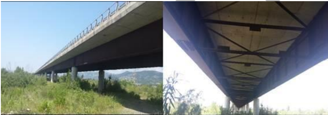
Figura 3-35 Urë ekzistuese mbi Lumin Mat - Pamje e këmbëve trarëve prej çeliku dhe pllakave me beton arme
