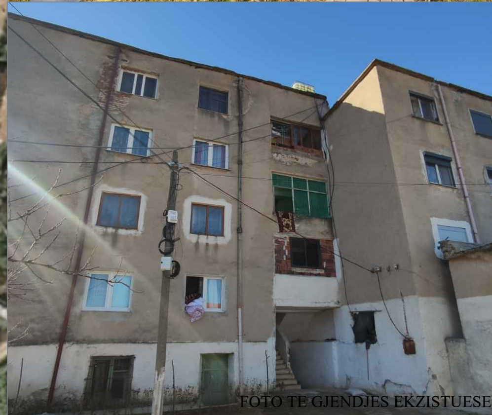
FOTO TE GJENDJES EKZISTUESE
