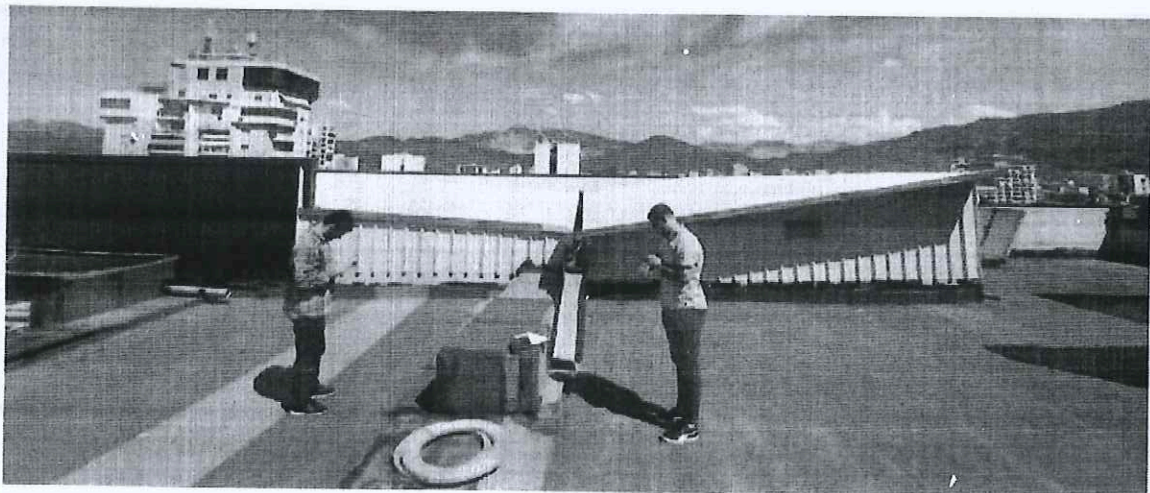
Foto 3: Çati e pjerrët me panele sanduic
