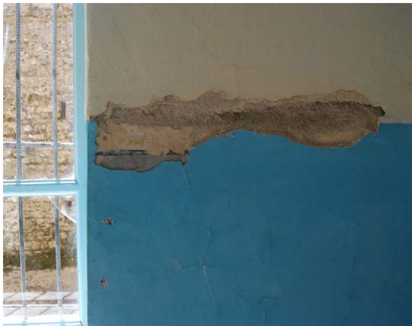
Figure 10 Mungesa e suvasë së brëndshme në ambientet e gjimnazit
