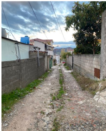
Foto te Gjendjes Ekzistuese
