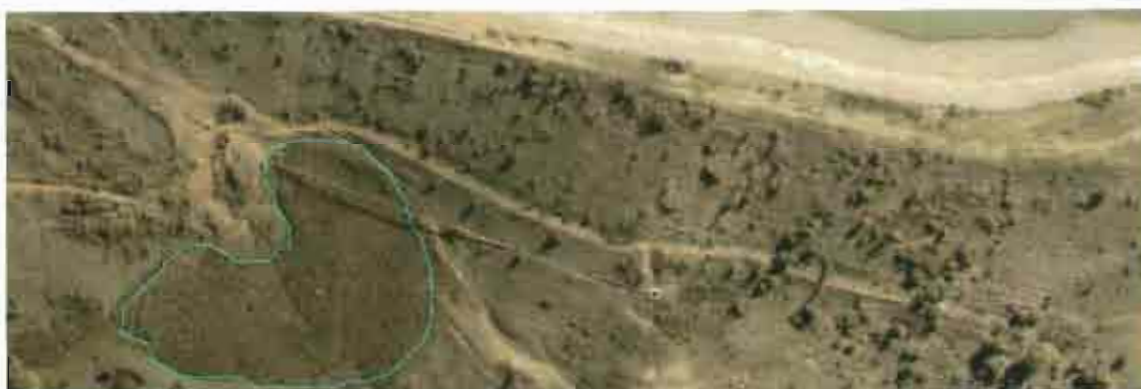
Figura 3-4 Skarpata e bjefit të poshtëm dhe zona me filtrime
