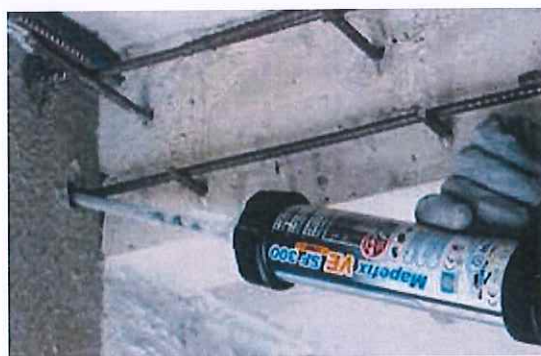
Menyrë e aplikimit të Mapefix EP 470 Sizmike (OSE EKUIVALENTI I TIJ)
